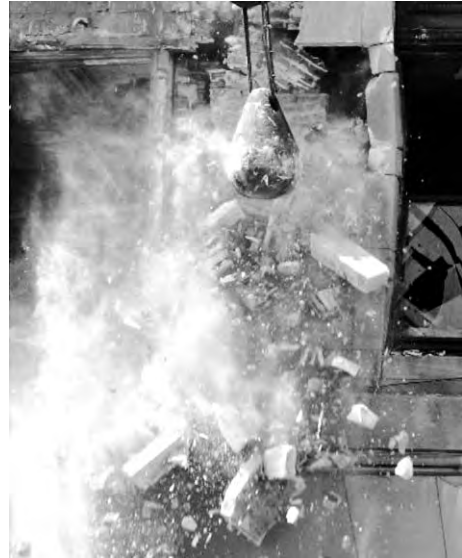
slopen met een sloopkogel
