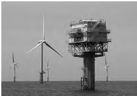
Zwemmen dolfijnen hier tussendoor? Het Prinses Amaliawindpark bij IJmuiden. © Werry Crone / Trouw
