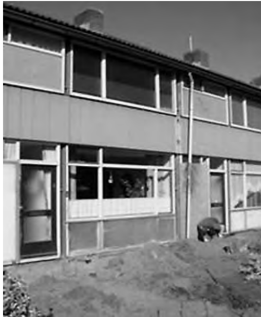
foto 1 Voor de renovatie
