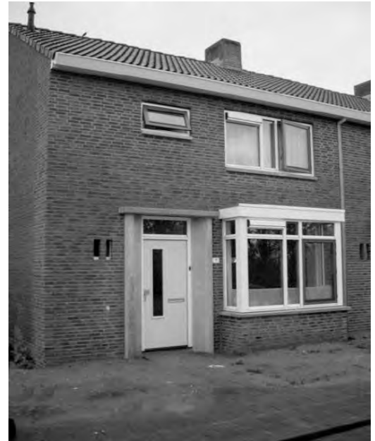
foto 2 Na de renovatie
